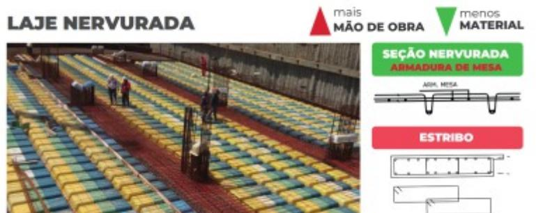
Laje nervurada com aplicação de cordoalha, visando redução de volume de concreto, porém devido a maneira que é projetada (lajes apoiadas sobre vigas), tem estribos nas vigas/ vigas-faixa e armadura longitudinal.
