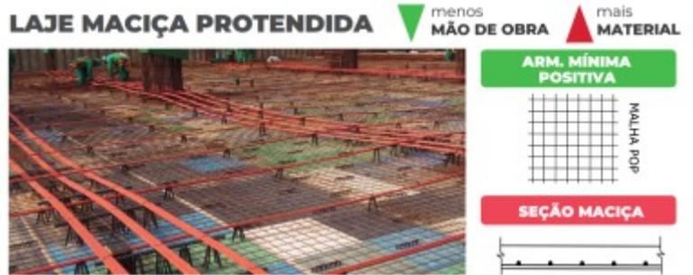
Laje maciça protendida, conforme modelo americano. Laje caracterizada por uma fácil montagem, porém com um elevado consumo de concreto.
