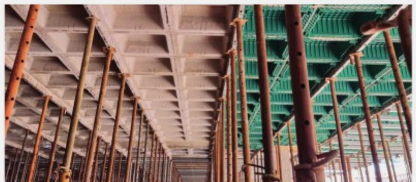
Cimbramento da Impacto com formas plásticas (cubetas e Plasterits), permitindo desforma simplificada das longarinas e formas a partir do 3º dia do concreto.
