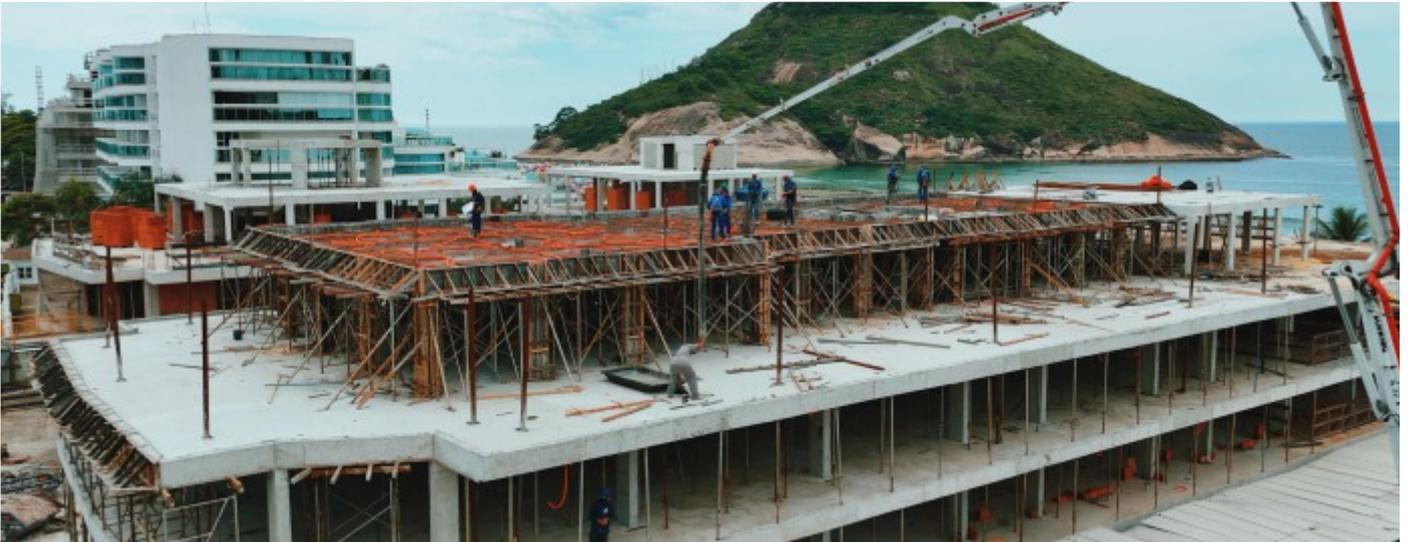
Localizado na zona oeste carioca, o Residencial Las Ventanas (empreendimento da MR2 Construtora em parceria com a Rio Fôrmas) contou com aproximadamente 100 toneladas dos sistemas de escoramentos TIPFlex para a execução de sua estrutura, composta por lajes maciças em concreto armado. Com três blocos e mais de 20 mil m<sup>2</sup> construídos, o edifício é privilegiado pela vista exuberante e acesso direto à orla da praia do Pontal, no bairro do Recreio.
