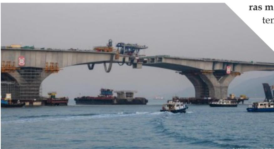
para facilitar o acesso dos trabalhadores em áreas difíceis, minimizando o impacto ambiental e o uso de estruturas de apoio no solo.
