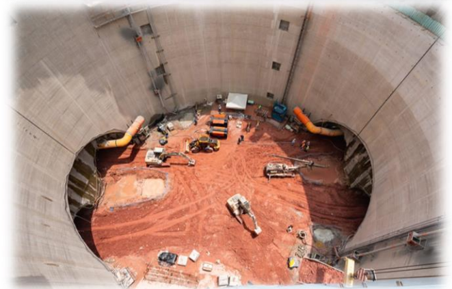
Revestimento Secundário e início da Escavação do Túnel
