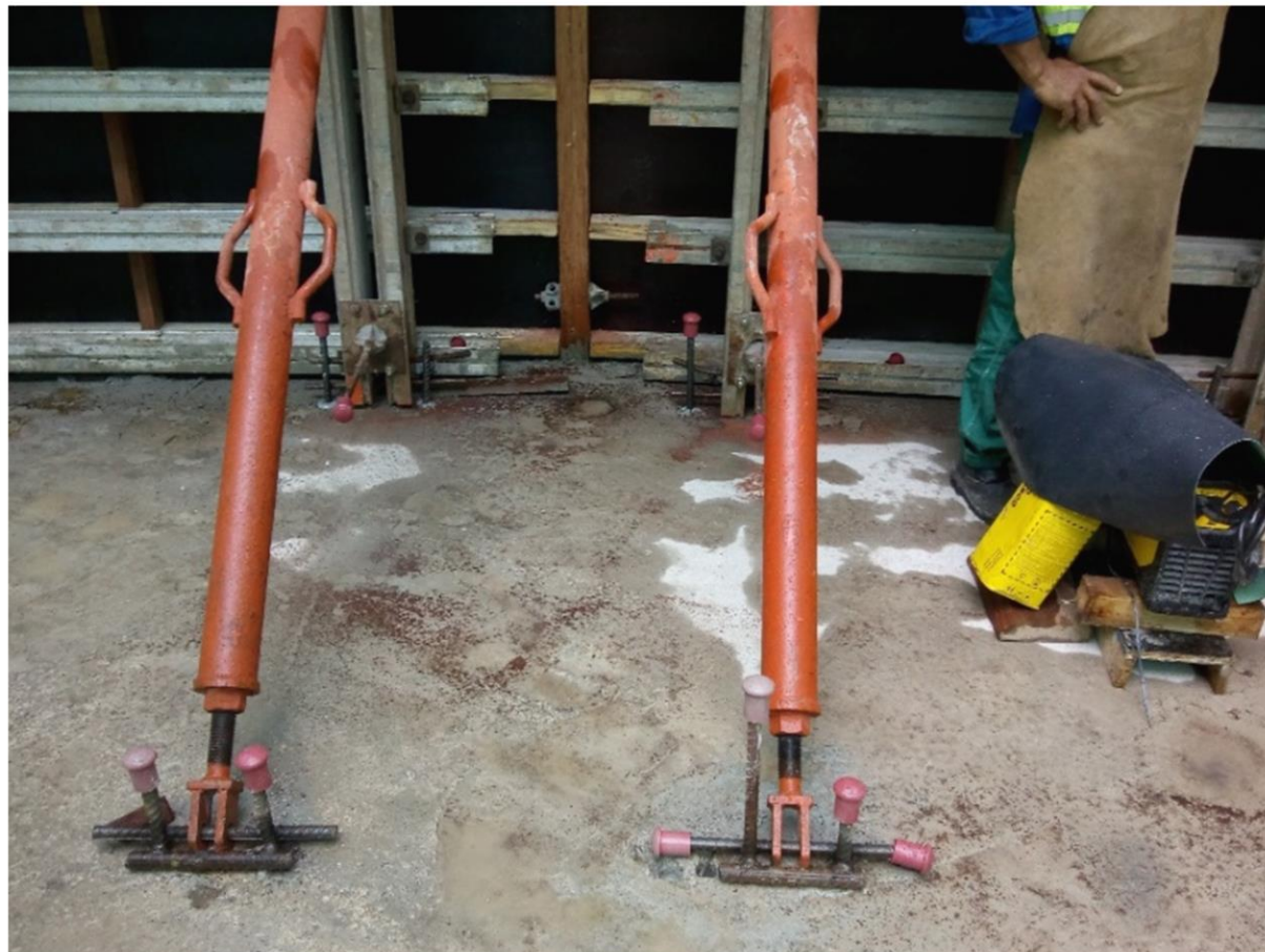
Detalhe de chumbamento da base da fôrma e tensores na 1ª Etapa de concretagem
