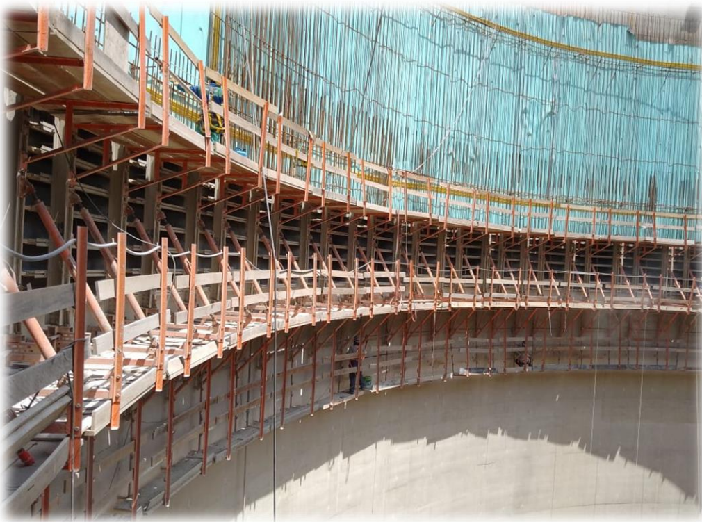
Sistema de Fôrmas Trepantes
