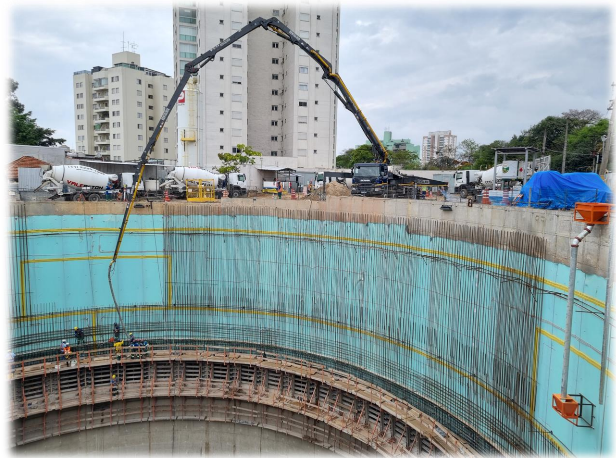
Concretagem das paredes de revestimento secundário
