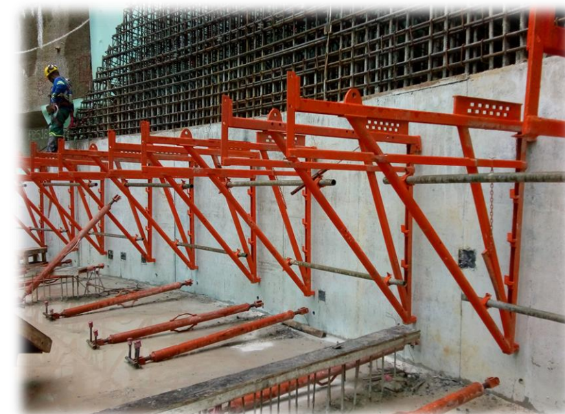
Consoles trepantes ancorados no cone metálico
