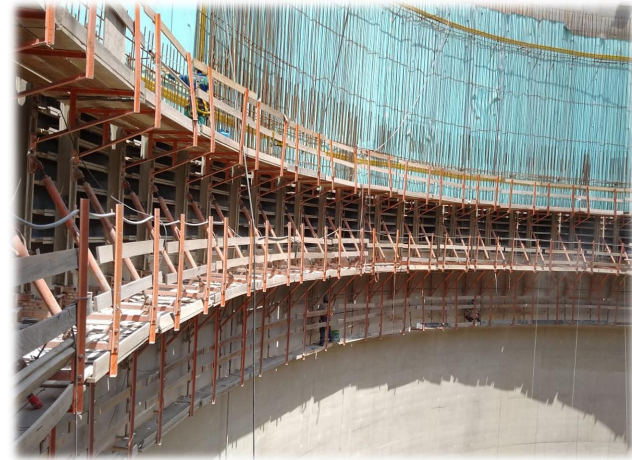
Sistema de fôrmas trepantes montado
