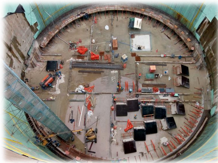
Praça de trabalho para limpeza das fôrmas
