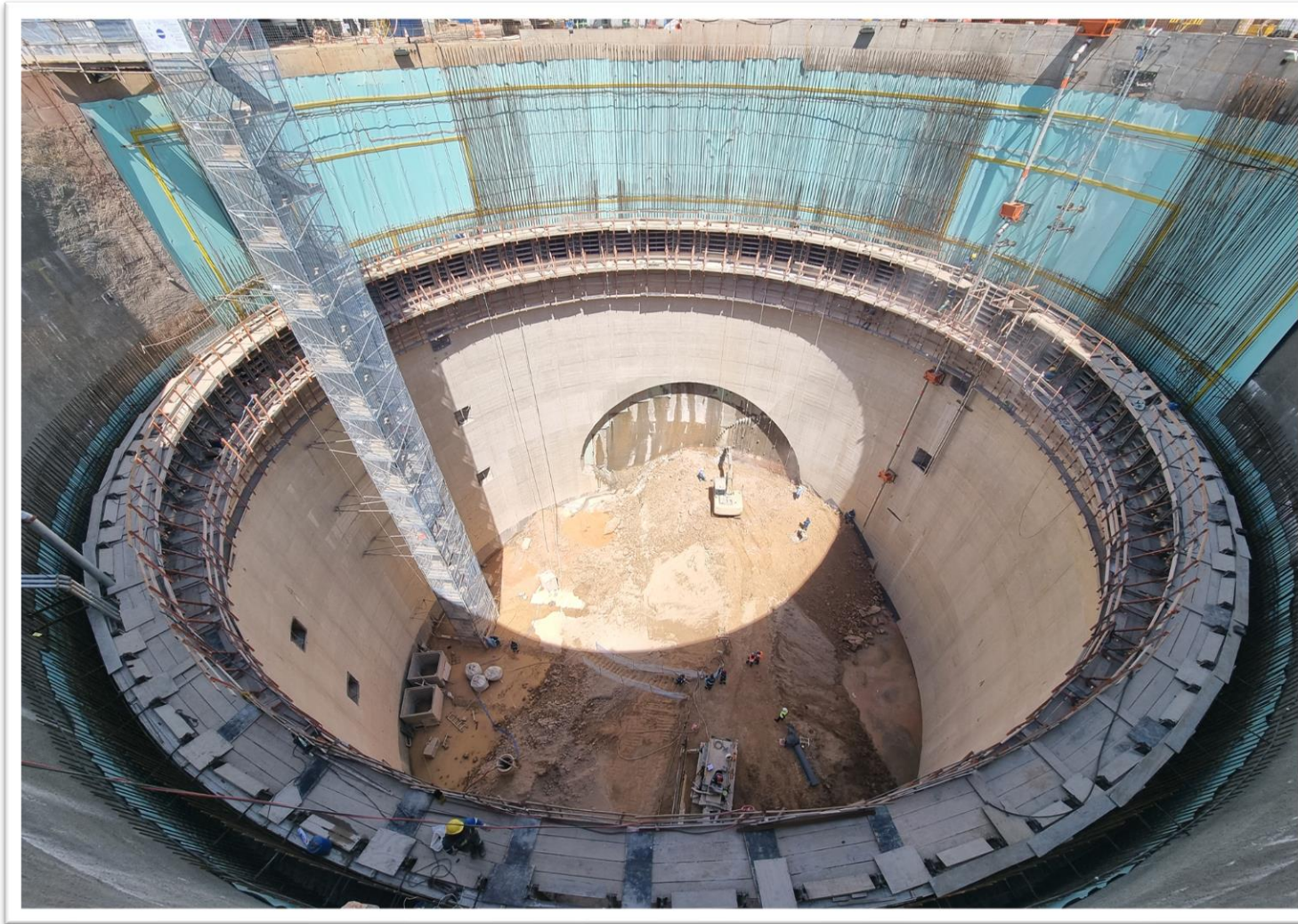
Sistema de fôrmas trepantes do Poço de Acesso Principal da Estação Vila Formosa
