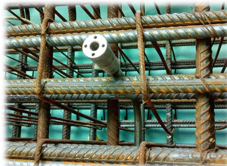
Cone metálico (recuperável) para ancoragem das fôrmas
