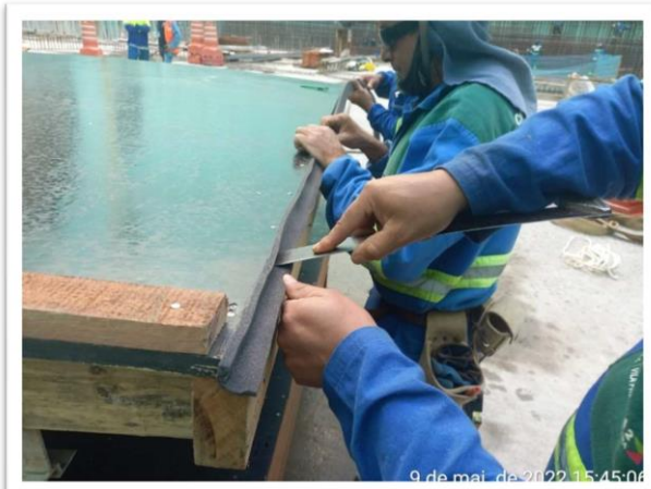
Colocação da fita adesiva de espuma
