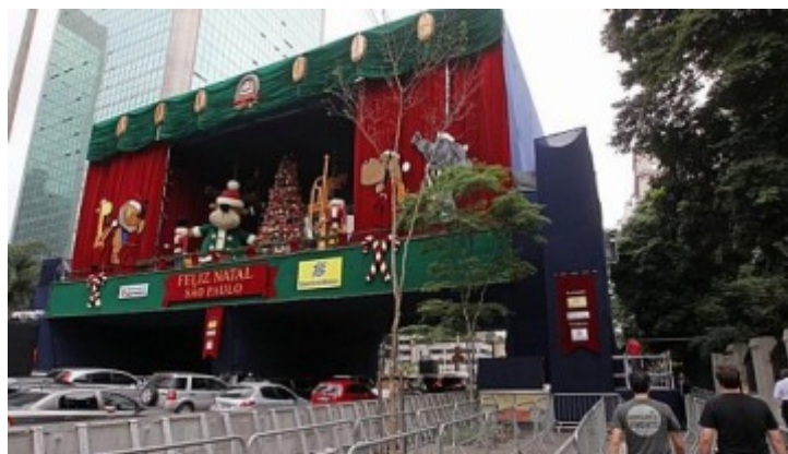
Estrutura para a festa de Natal e Réveillon na Avenida Paulista: composta, basicamente, por três linhas de torres de encaixe que servem de apoio para os dois vãos montados com treliças, vencendo um vão de 16.
