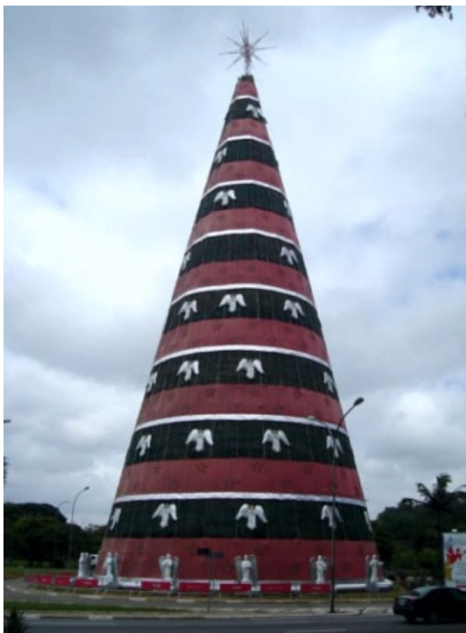
Estrutura para montagem da árvore de Natal no Parque Ibirapuera: foram utilizadas aproximadamente 95 toneladas de equipamentos metálicos e mais 65 toneladas de contrapeso para a estabilidade da estrutura.
