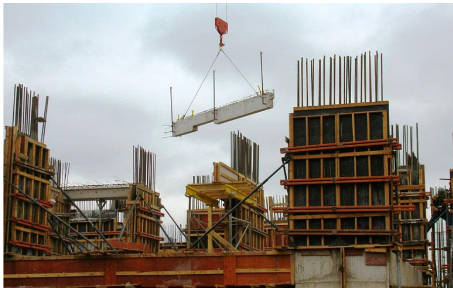
Fôrma de madeira
