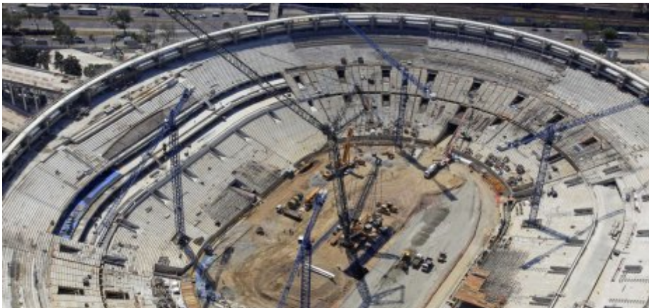
Reparo e proteção do concreto dos pilares, vigas, paredes e sessões cortadas utilizando a argamassa polimérica (2013). Foto Exemplo Engenharia.
