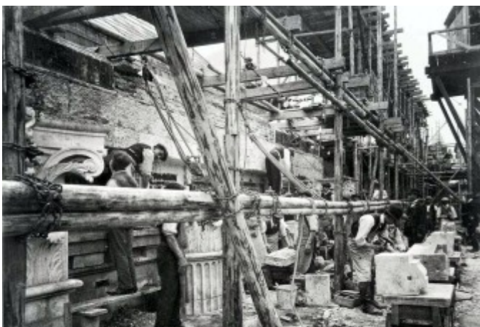
Reforma do Palácio de Buckingham em 1913, utilizando o sistema de andaimes Scaffixer.
