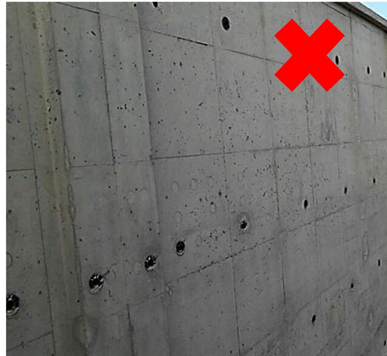
**Deslizamento: Ausência de Juntas de concretagem.**
