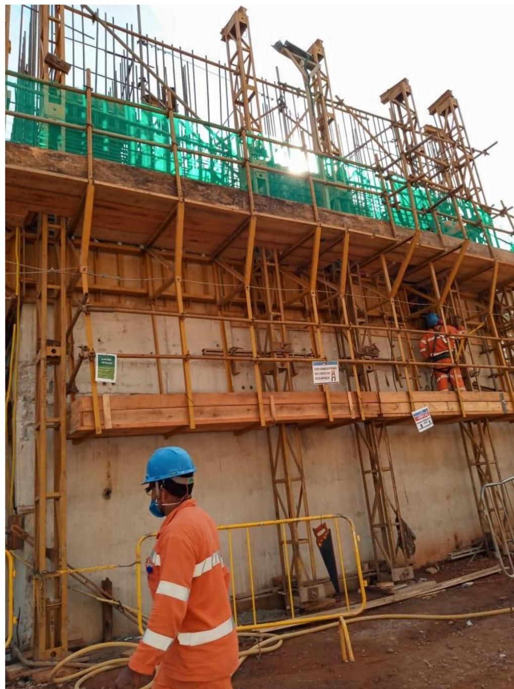
O acabamento realizado de imediato, elimina os reparos inevitáveis nas concretagens com a utilização de outro tipo de fôrma, além de tornar a estrutura monolítica, sem juntas de concretagem.
